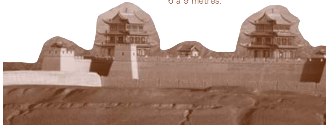
Fig.6 : Dans la province du Gansu, les sections de la Grande Muraille datant de la dynastie Ming (1368–1644) furent érigées en terre damée pour pallier la pénurie locale de pierre. Ces remparts atteignent par endroits une hauteur de 6 à 9 mètres.
