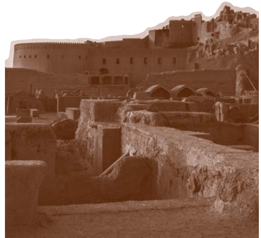
Fig.5 : Fondée au VI e –IV e siècle av. J.-C., la Citadelle de Bam en Iran, est la plus grande structure en adobe du monde. Cette ville fortifiée couvre environ 180 000 m 2 et est entourée de remparts allant jusqu'à 7 mètres de haut.
