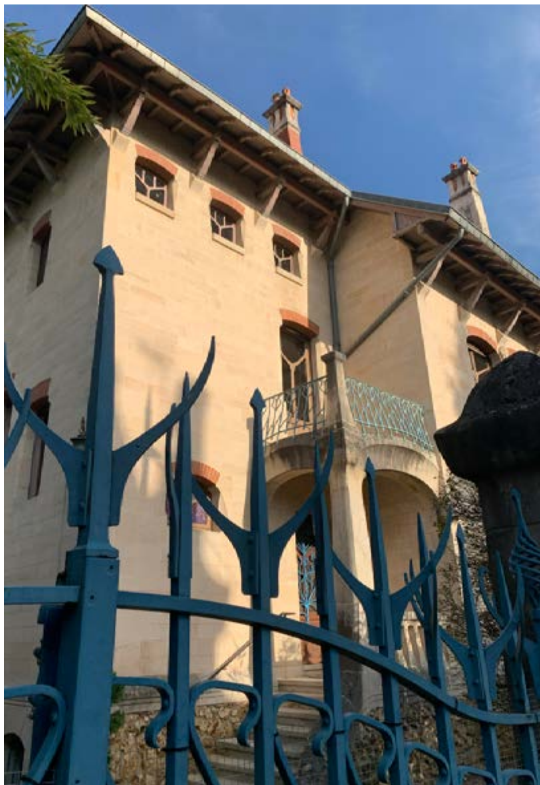
Fig 91 - Sur la «Villa des Glycines» j'ai remarqué le travail Art nouveau au niveau des diverses grilles, du balcon ainsi que sur les fenêtres aux formes organiques, Parc de Saurupt
