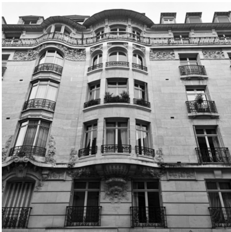
L'immeuble, 10 Rue Puvis de Chavannes, 75017 Paris. Photographie personnelle
