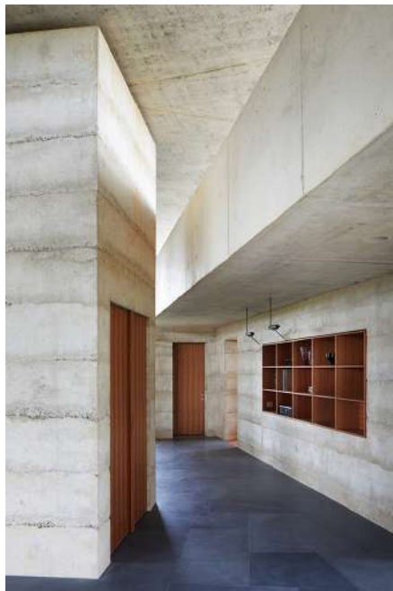
HOBHOUSE Jack, Secular Retreat , détail du béton à l'intérieur.
