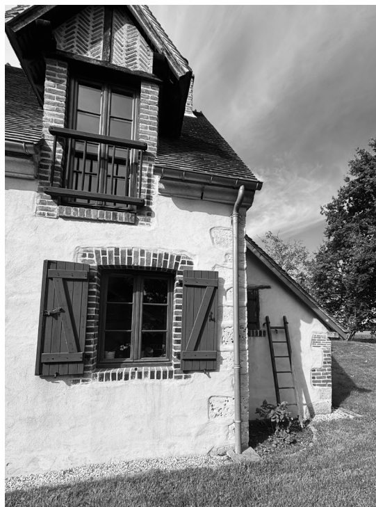
Façade maison, pierres de l'abbaye, photographie personnelle, 2025
