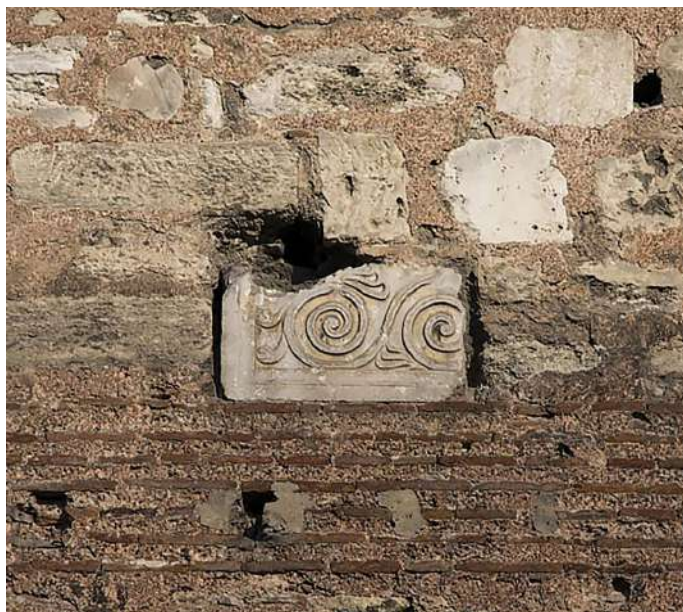
Mur d'enceinte, Istanbul.
