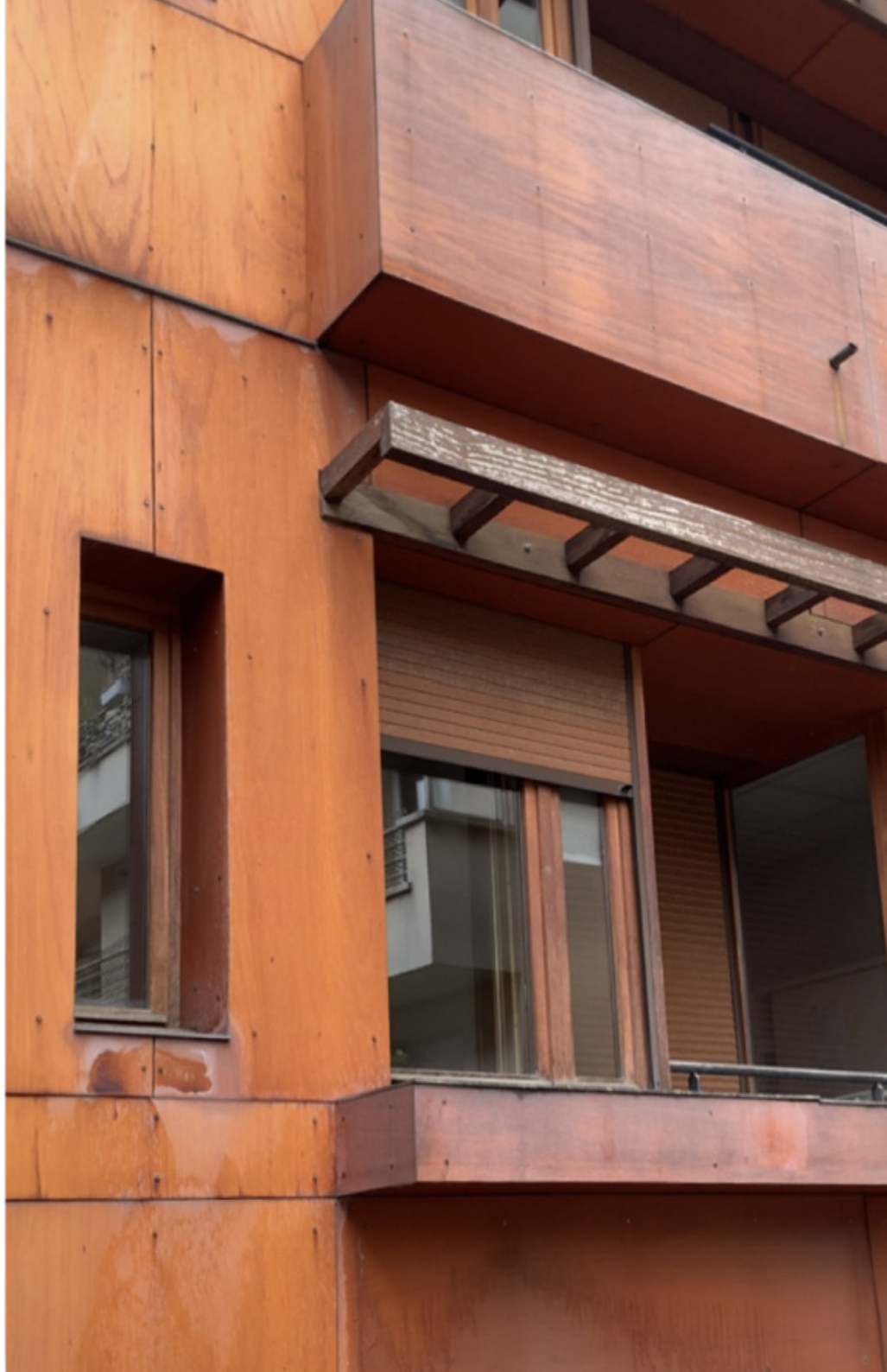
Détail, façade Sud - Nord
