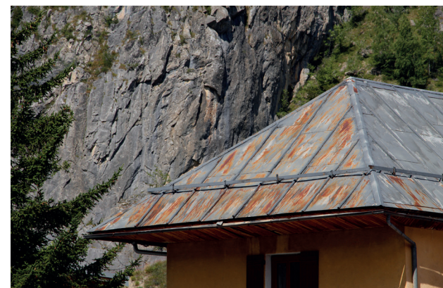
Photographies personnelles, Toits des chalets de Valloire, 2025.
