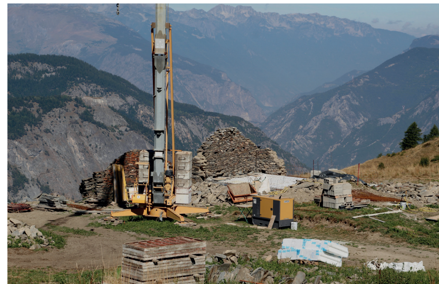
Rénovation d'une ruine d'un chalet d'alpage à Valmeinier, photographie personnelle, 2025.
