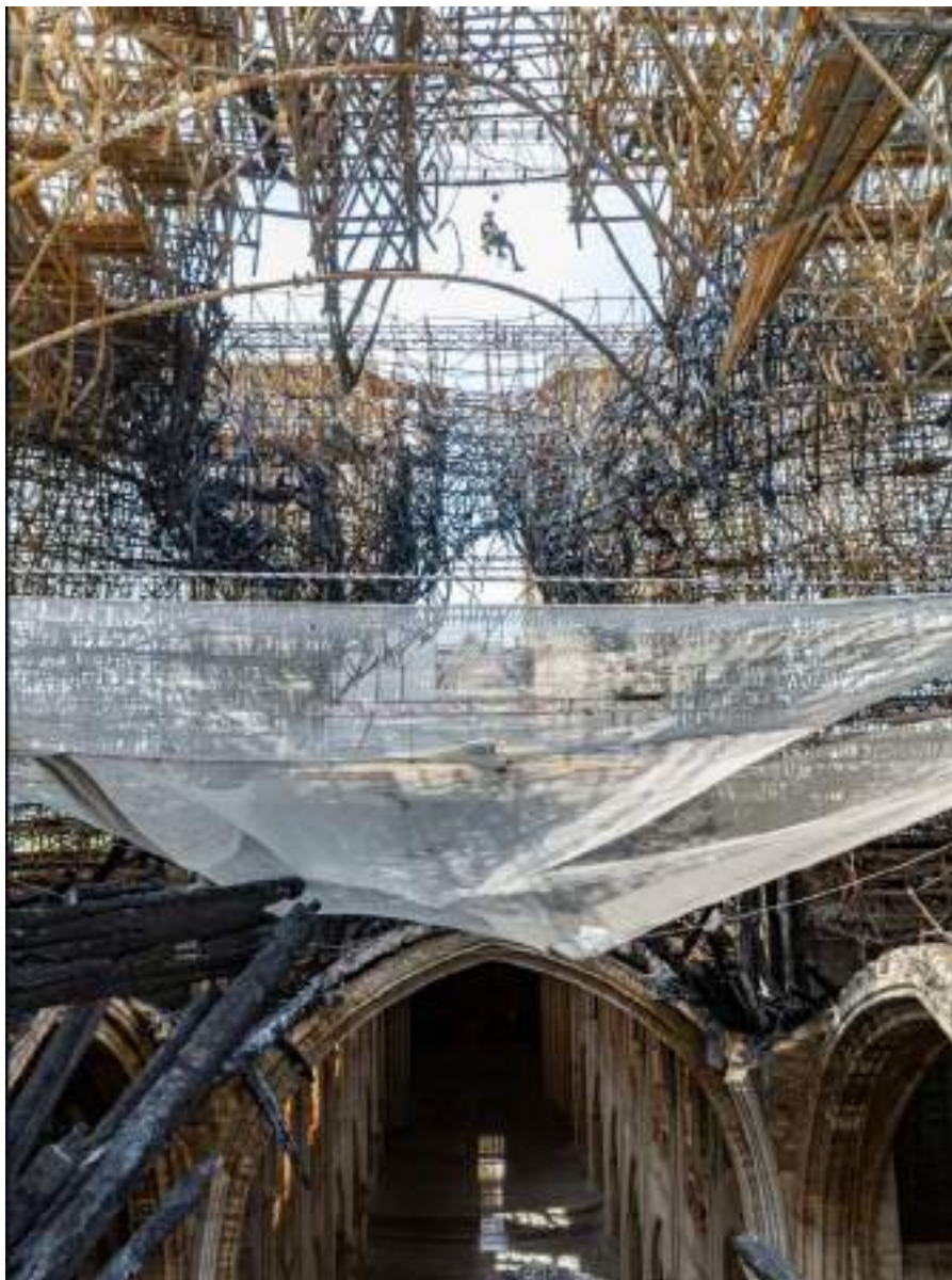
Fig.38 : Un cordiste inspecte l'échafaudage sinistré, 2020 © C2RMF / Alexis Komenda
