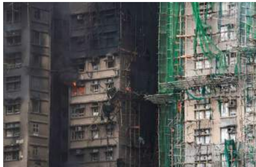
Fig.25 : Échafaudages sur la résidence Wang Fuk Court, à Tai Po, Hong Kong, le 27 novembre 2025. Bertha Wang/CNN.
