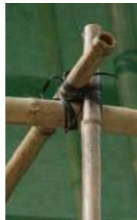
Fig.26 : Assemblage échafaudage en bambou, CNN, 2025
