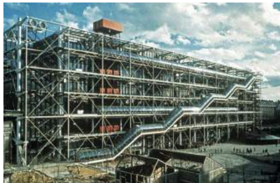
Fig.69 : Construction de la façade Ouest du Centre Beaubourg, Georges Meguerditchian, Centre Pompidou, © Bibliothèque Kandinsky, Dist. GrandPalaisRmn.
