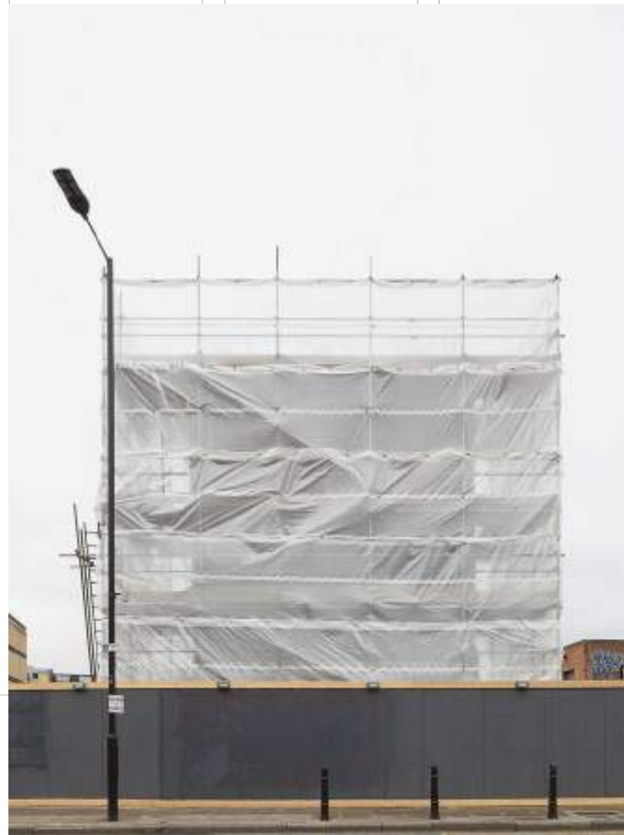
Fig.50 : Francisco Ibáñez Hantke, Les structures inachevées au premier plan dans la série photographique, 2019
