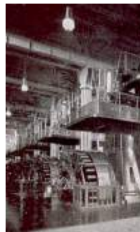
Fig.12 : Salle des machines de l'usine du quai de Jemmapes de la Compagnie parisienne de l'air comprimé , à Paris, photographie, s.d.
