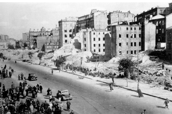
Travaux de reconstruction de la rue Khrechatyky. © Archives centrales d'État du cinéma, de la photographie et du son de l'Ukraine.
