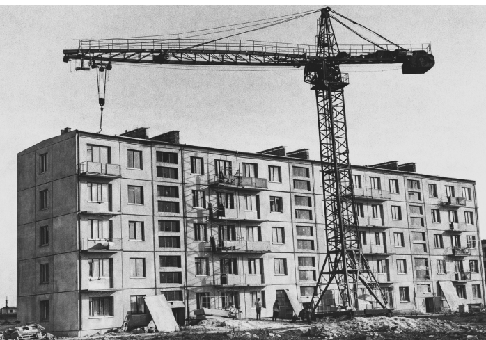
Immeuble d'habitation de la série 1-464 à Kharkiv. Construction résidentielle de masse, 1966. © Journal « Kommunist ».
