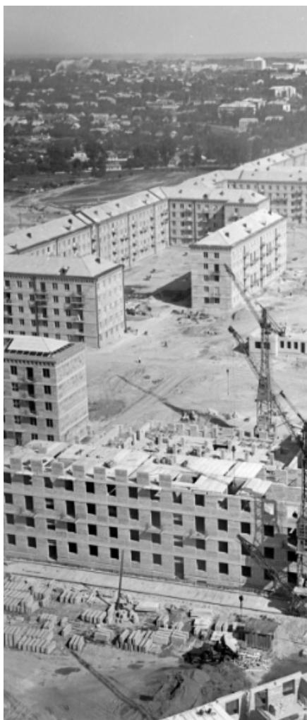
Construction de logements collectifs à Kyiv. Fin des années 1940 – début des années 1950.
