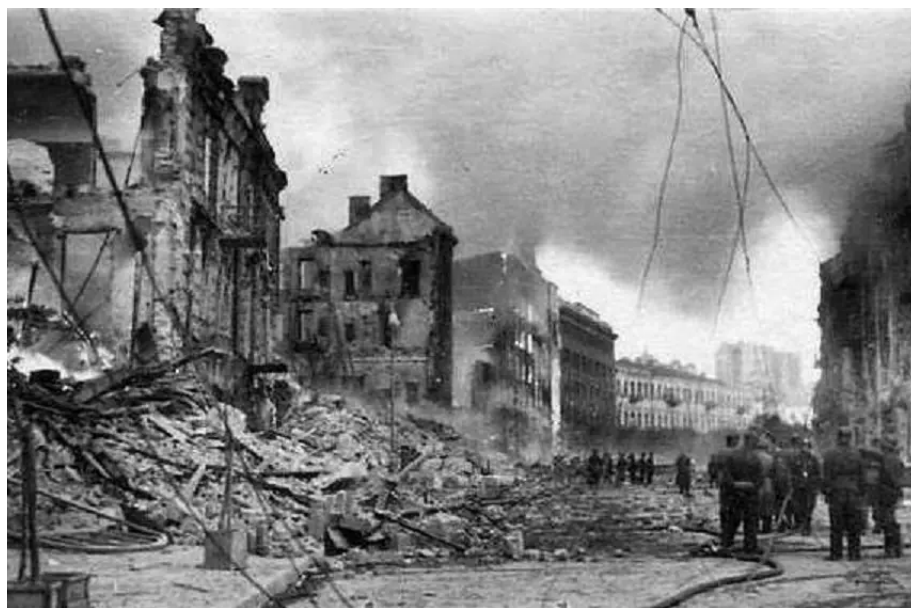
Destructions de l'avenue Khreshchatyk après les explosions et les incendies de 1941. Kyiv.
