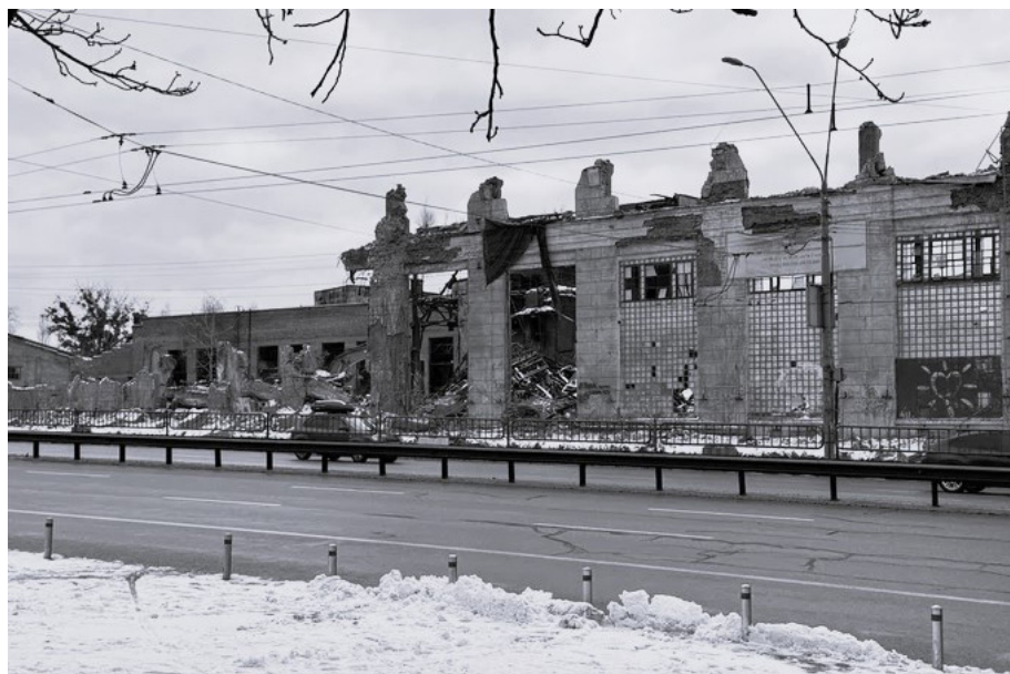
Démantèlement d'un atelier de l'usine « Bolchevik » en vue de la création d'un échangeur routier.
